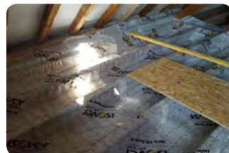
Pare-vapeur dans la structure bois © Cellulhome
