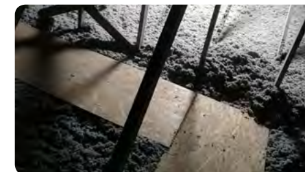
Pose d'une finition de sol © Waleco
