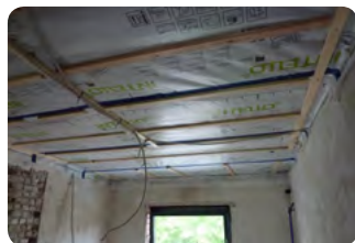
Pare-vapeur sous le plancher © samennele.blogspot
