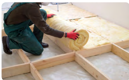
Isolant souple dans une structure bois
