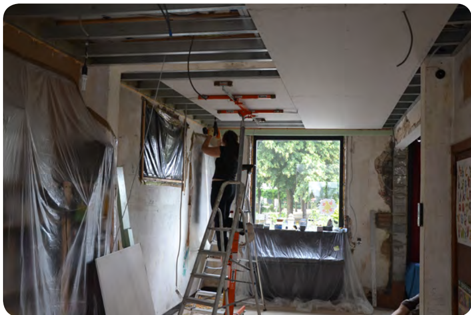
Finition de plafond sous la structure © samennele.blogspot
