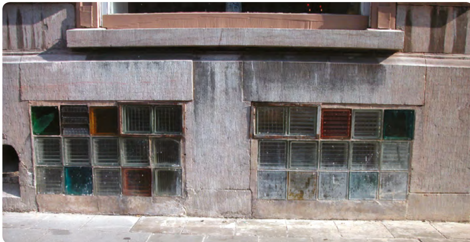
Fenêtre de cave bouchée par des briques de verre
