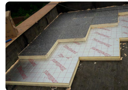
Pose de l'isolant sur l'étanchéité existante
