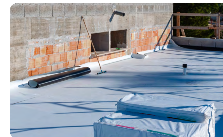
Mise en œuvre d'une membrane en EPDM
