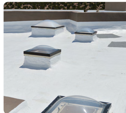
Étanchéité recouverte d'une peinture réfléchissante
