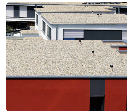
Étanchéité protégée par un lestage de teinte claire
